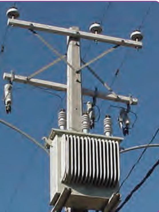
En algunos postes del tendido eléctrico es posible observar transformadores como los de la imagen, que reducen el voltaje de la red de distribución, hasta los 220 V.
