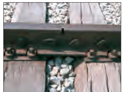
Entre las líneas férreas existe una separación que permite que estas se dilaten por efectos de la temperatura, sin que ellas se deformen por compresión.
